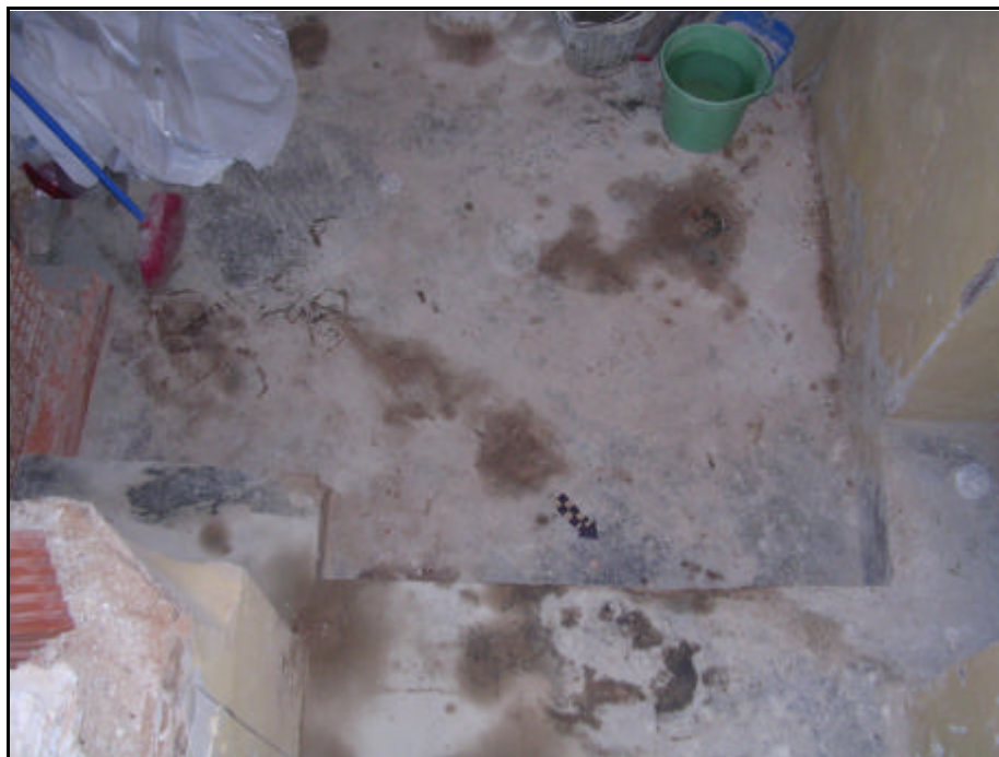
Fotografia 2: Lloc on s'ha de realitzar el fossat
